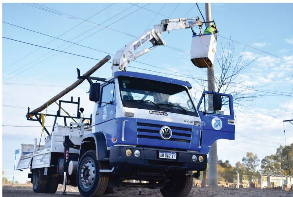
Recambio de Luminarias en Parque Industrial I
