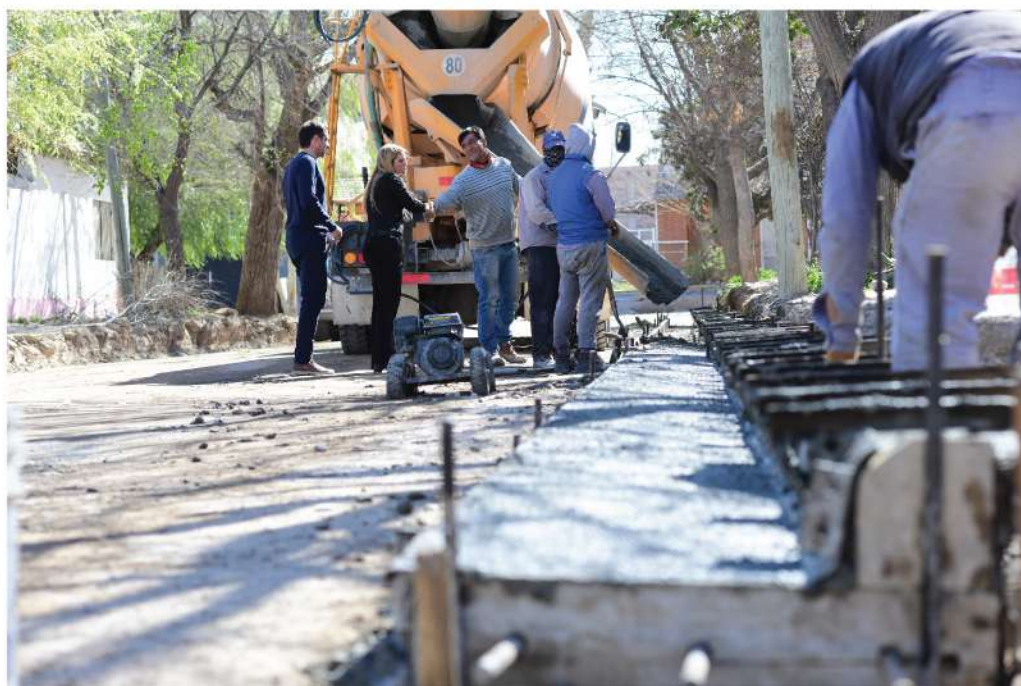
Pavimento Zona Norte - Noroeste
