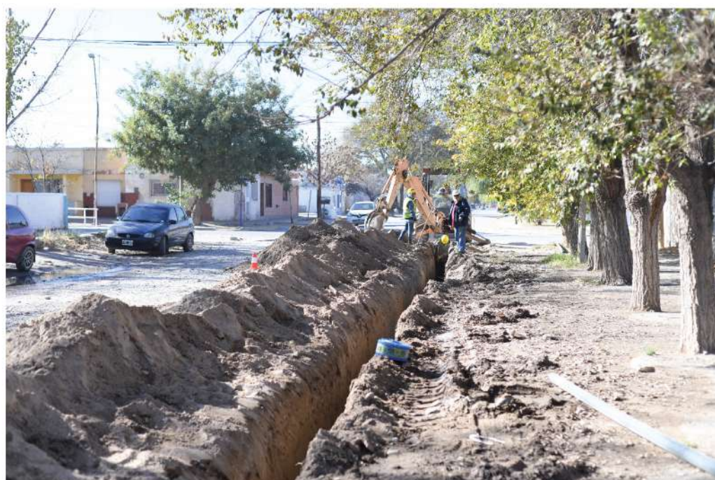
Pavimento Zona Norte - Recambio de cañerías en Alfonsina Storni
