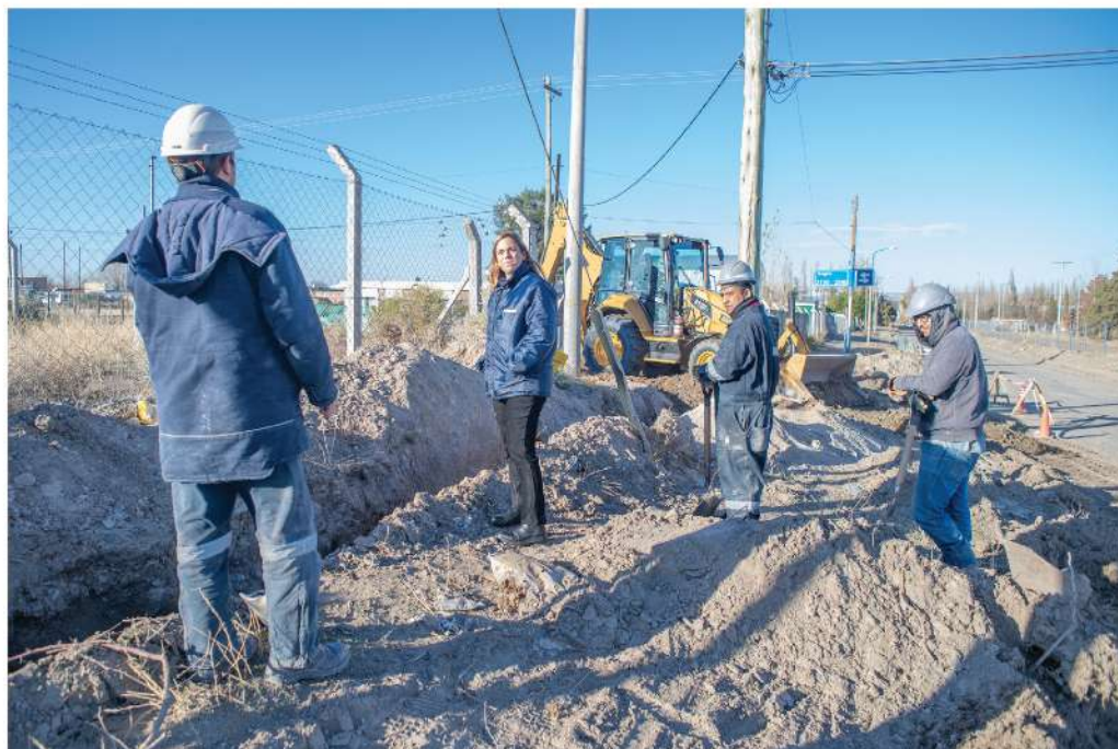
Red de Gas en Parque Industrial I
