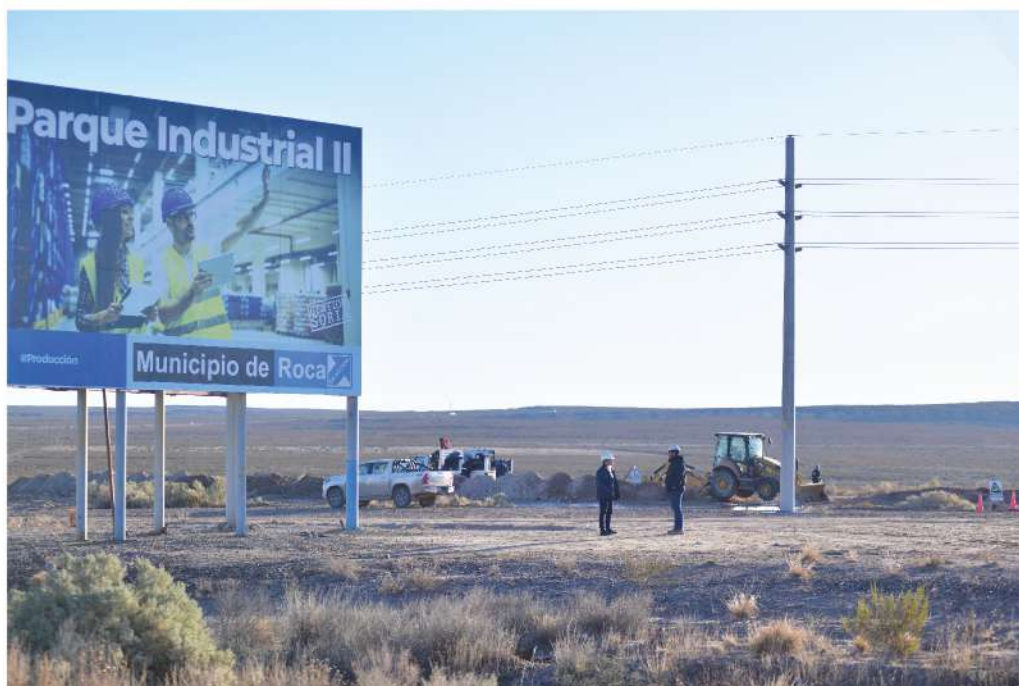
Red de gas intramuro en Parque Industrial II
