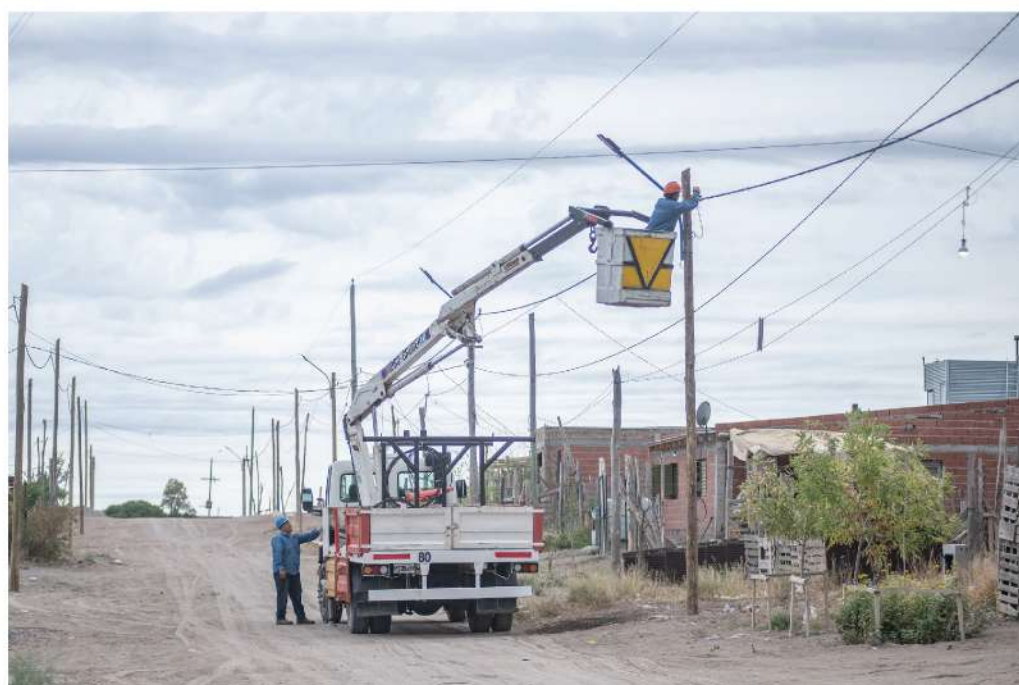
Electrificación Quinta 25 Norte
